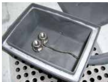
Soudobrasage dans caisson de mise sous gaz
